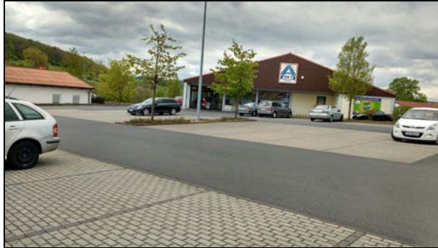
Abb. 2: Blick über die Stellplatzfläche auf den bestehenden Aldi-Markt
